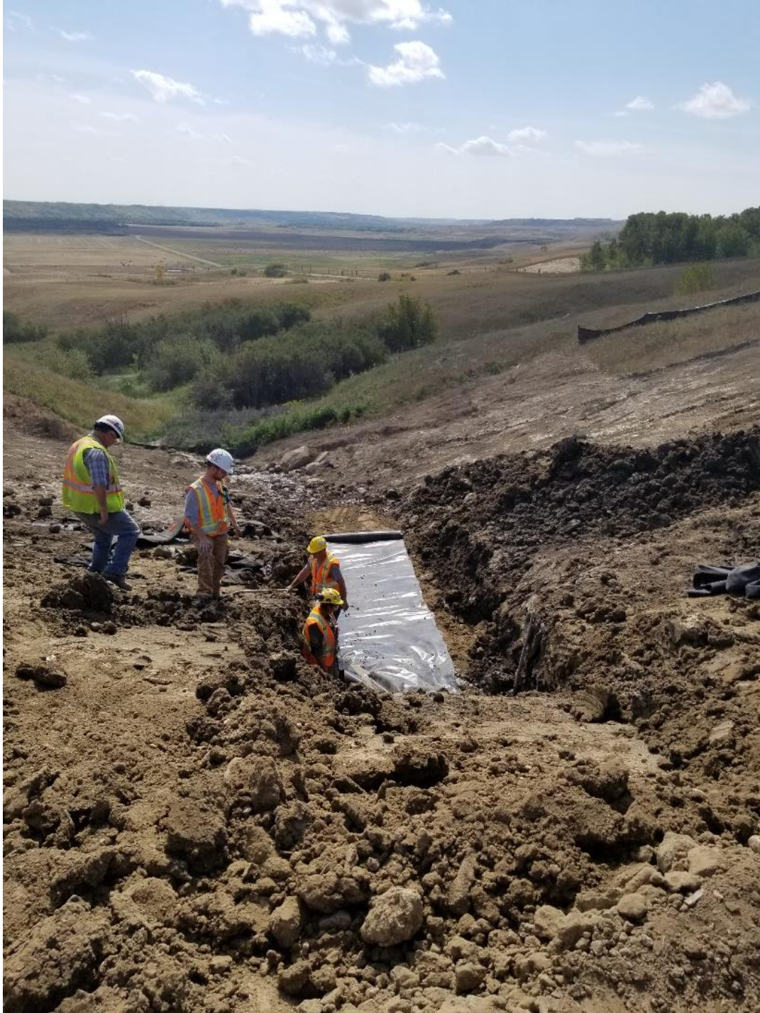
Drainage installation at the Qu'Appelle Valley.
